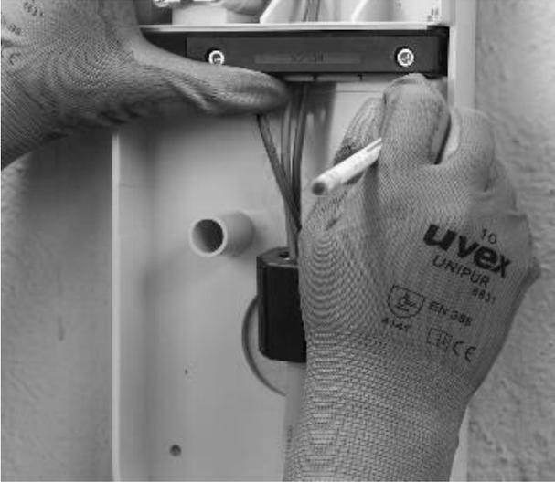
17. À l'aide d'un foret de 8 mm, percez des trous de 50 mm de profondeur aux endroits préalablement marqués sur le mur. Installez les 4 prises murales.
